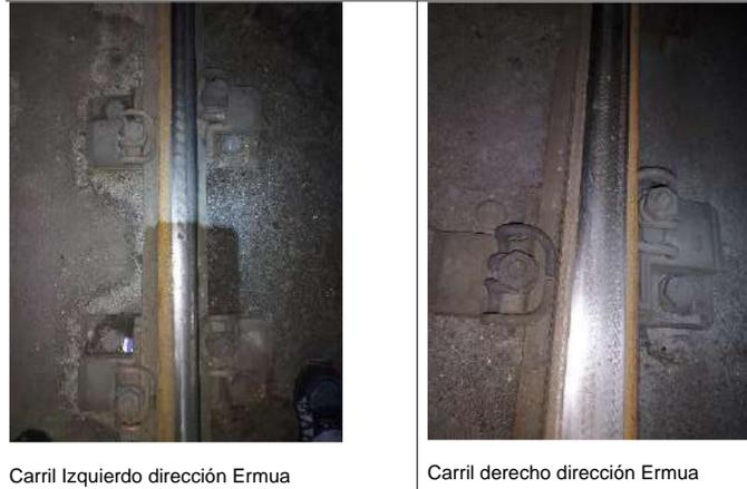
Figura 19. Defectos en la vía zona 1 – Placa. Vía 1.
