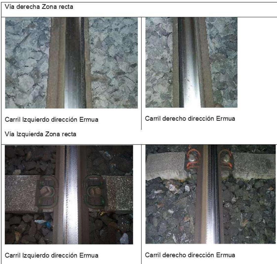
Figura 27. Defectos en la vía Tramo 3 – Zona recta.
