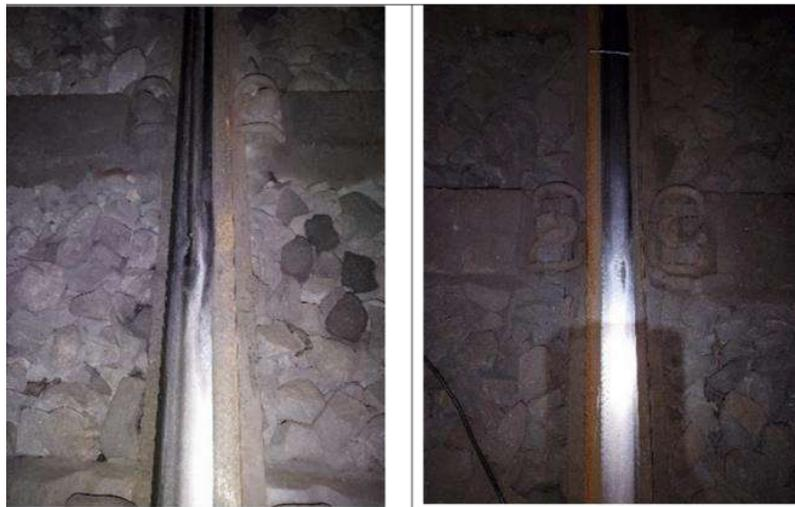
Figura 16. Defectos en la vía en el límite del Tramo 1 – Balasto entrada estación.
