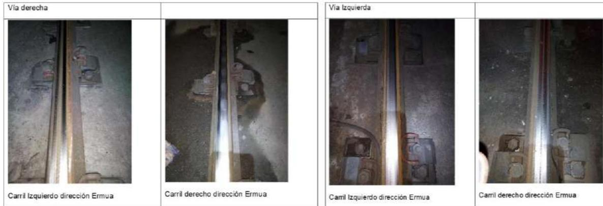
Figura 20. Defectos en la zona de andenes – Placa. Las dos primeras Vía 2 y las segundas Vía 1.
