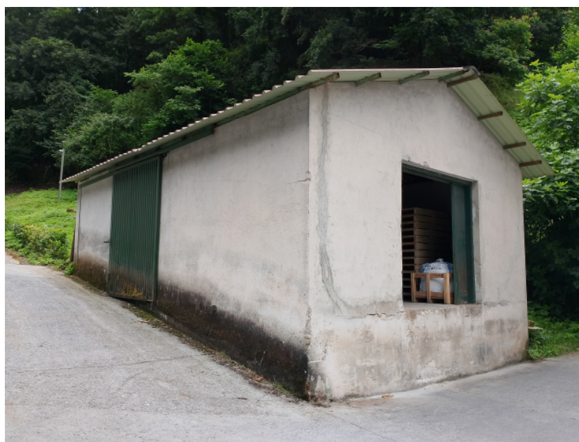
Figura nº17: Actual almacén previsto demoler para la construcción del nuevo almacén de balas
