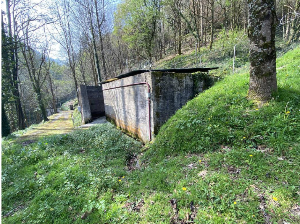
FOTO 16 POLVORIN F (A DEMOLER)
