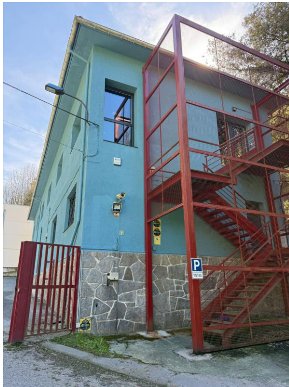
FOTO 2: ESCALERA DE ACCESO A OFICINAS
