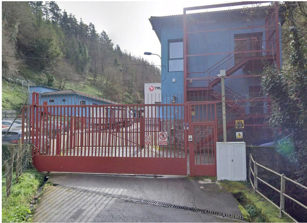
FOTO 1 ACCESO A LAS INSTALACION
