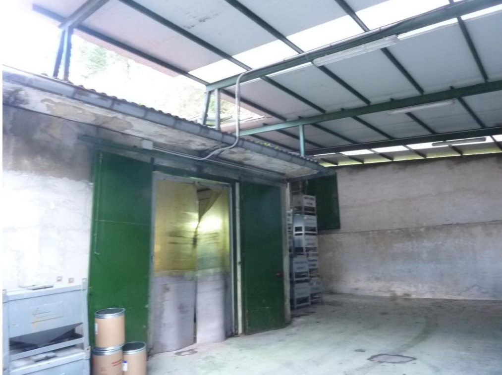
FOTO 10 CUBRICION ENTRE EDIFICO C Y B (A DEMOLER)
