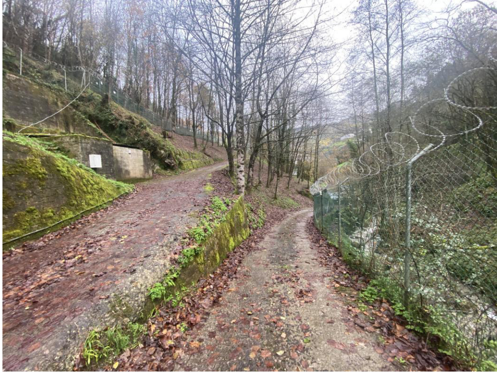
FOTO 14 CURVA A COTA DE LOS POLVORINES A LA IZQUIERDA EL POLVORIN E
