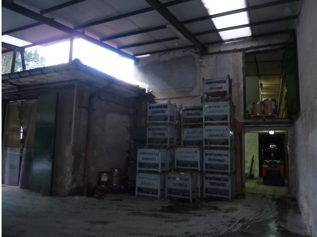
FOTO 9 CUBRICION ENTRE EDIFICIO C Y B (A DEMOLER)
