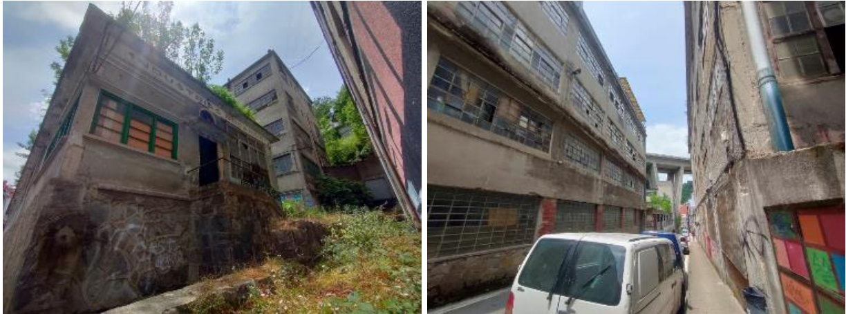
Foto 17. Rocando en primer plano y Automatismos Lau-Nik en segundo plano (izqda.). Foto 18. Transformaciones metalúrgicas Norma SA (dcha.).
