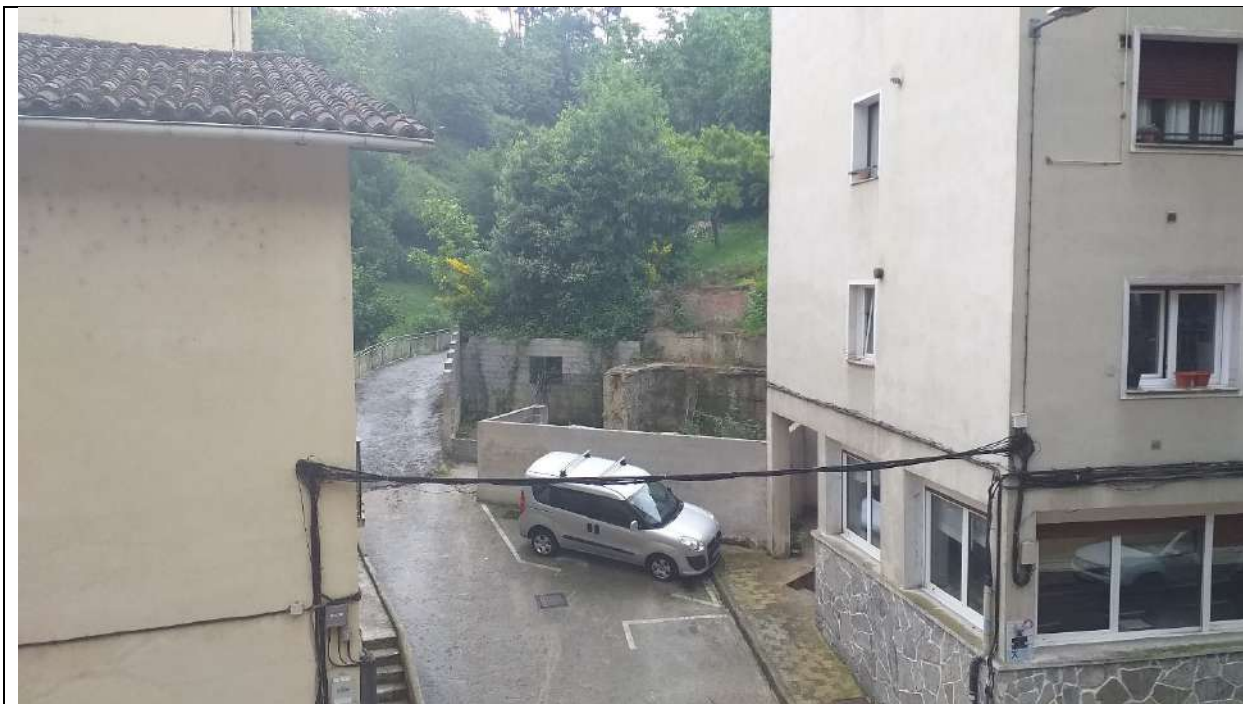
Restos de Nº 21 demolido, en Errekatxu Kalea
