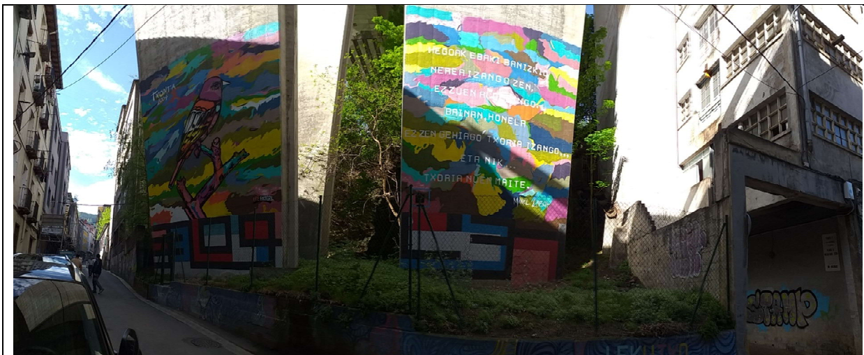
Imagen de las pilas del viaducto de la A8 sobre Txonta Kalea
