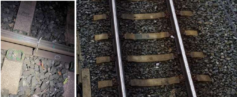
Figura 21. Infraestructura Tramo 2 – Balasto superficie.
