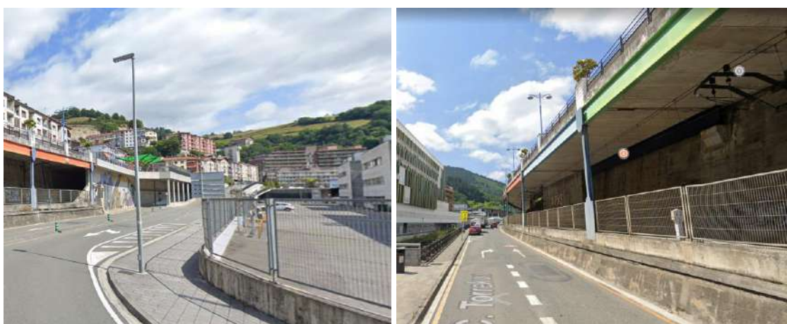
Figura 9. Tramo 4 – Vistas de la salida del túnel y cubierta zona hospital calle.
