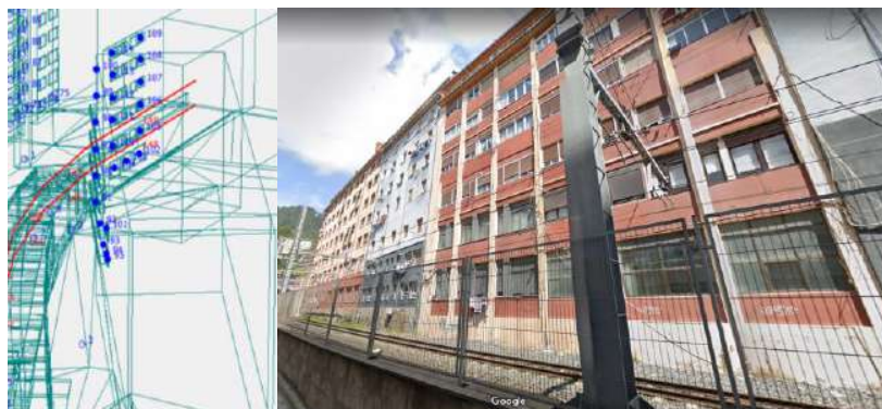
Figura 67. Vista de los edificios y distribución puntos de cálculo fachada de Legarre Kalea Nº 9,11,13,15, 17 y 19.
