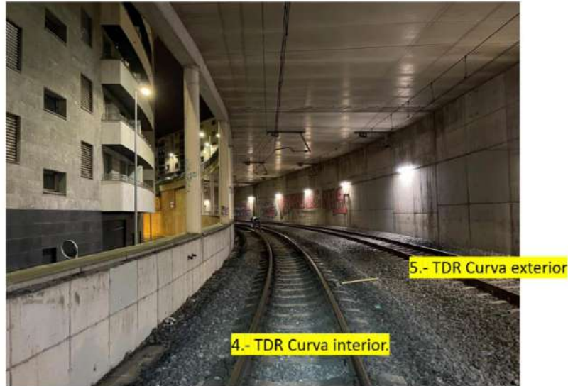
Figura 24. Infraestructura Tramo 3 – Curva interior y curva exterior.
