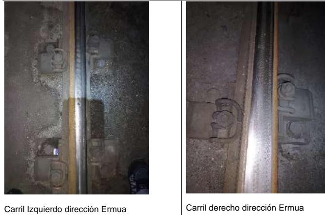
Figura 19. Defectos en la vía zona 1 – Placa. Vía 1.
