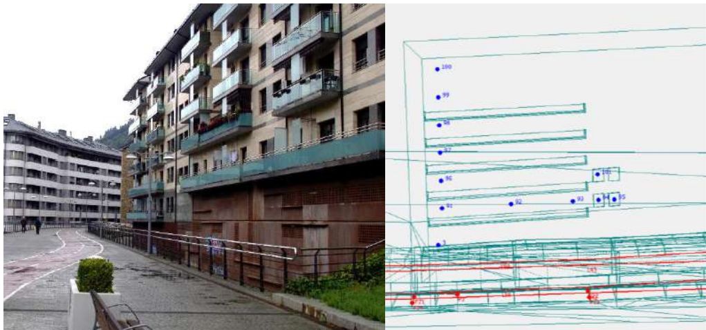
Figura 64. Vista del edificio y distribución puntos de cálculo fachada Arrate-Bide Kalea Nº 2 y 4
