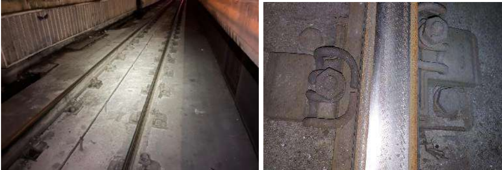
Figura 17. Infraestructura zona 1 – Placa.
