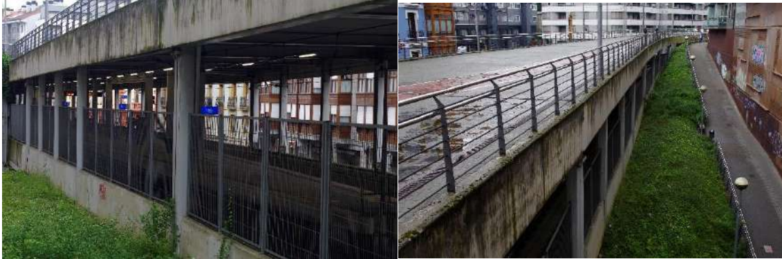
Figura 79. Tramo 1 – Detalle de las aberturas hacia Arrate-Bidea.
