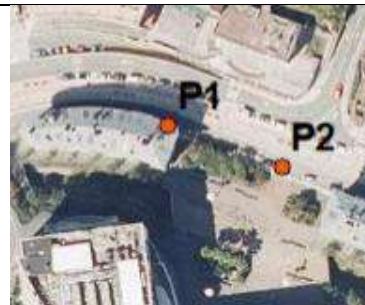
Figura 47. Tramo 3 – Puntos de medida de pasos de tren.
