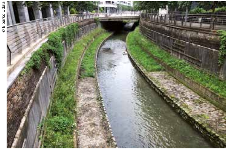
Encauzamiento y soterramiento del río Ego, en el centro urbano de Eibar
