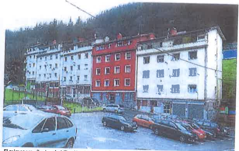
El primer estudio de rehabilitación contempla la construcción de ascensores y reformas. IZK. IX MORQUECHO
