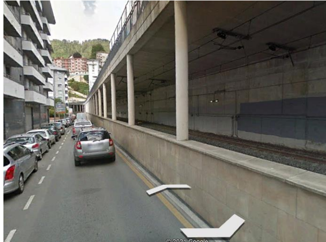
Muro y voladizo en san Andrés pasealekua
